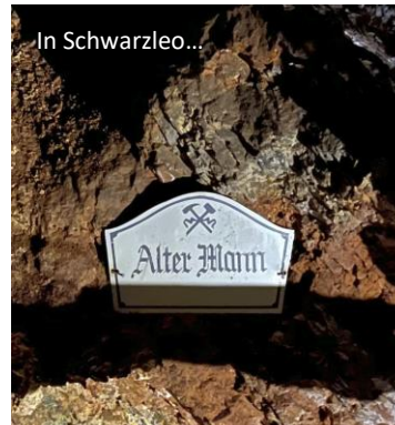
Als Alter Mann (auch der Alte oder Altermann, Mehrzahl: Altmänner) werden im Bergbau abgebaute und verlassene, mit Versatz gefüllte oder zu Bruch gegangene bergmännisch erzeugte Hohlräume bezeichnet.
